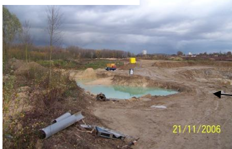
Travaux de terrassement pour les paléo-chenaux
