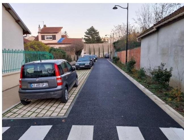
**Figures 10 : Création d'un parc avec infiltration des eaux pluviales à Fontenay-sous-Bois – SPL Marne aux Bois (photo de gauche) + Opération de désimpermeabilisation et de déconnexion des eaux pluviales de voirie à Joinville-le-Pont (photo de droite)**
