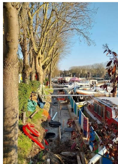
Figure 19 : Travaux de raccordement des bateaux du port de Joinville-le-Pont au réseau d'assainissement – EPT PEMB
